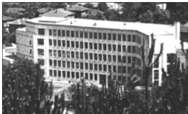
Болницата в Малко Търново, днес е в много добро състояние след извършените ремонти на сградата и оборудването ѝ с нова медицинска и физиотерапевтична апаратура.
