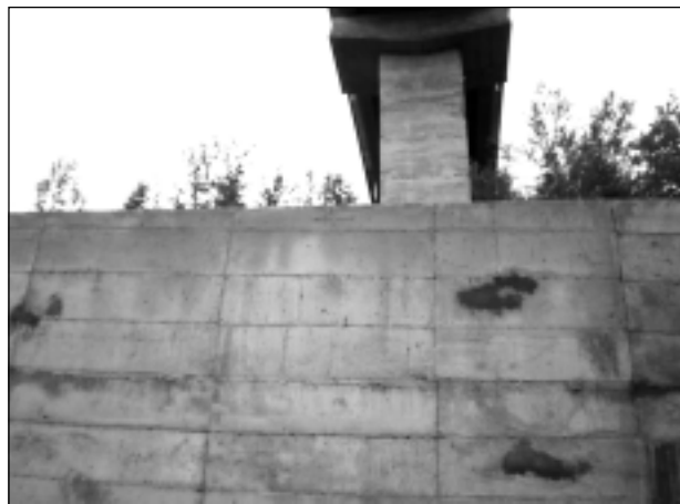
Подпорната стена под стоманобетонен мост над р. Велека“, м. Ковач.
